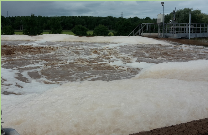
Ancien système d'aération
