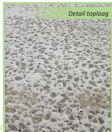
Realisatie van 4000 m 3 asfalt met oliebestendige toplaag
