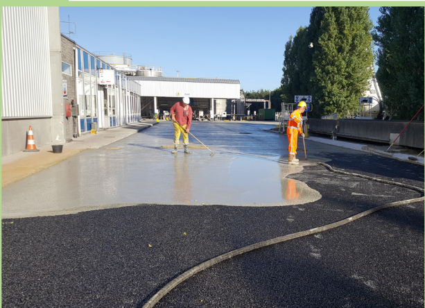
Realisatie van 4000 m 3 asfalt met oliebestendige toplaag
